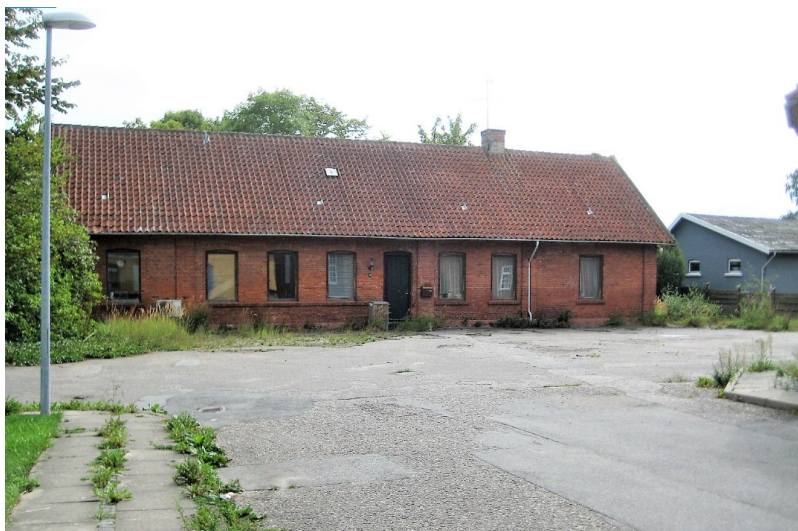
Jernbanegade 18 i Dybvad, før nedrivning.
