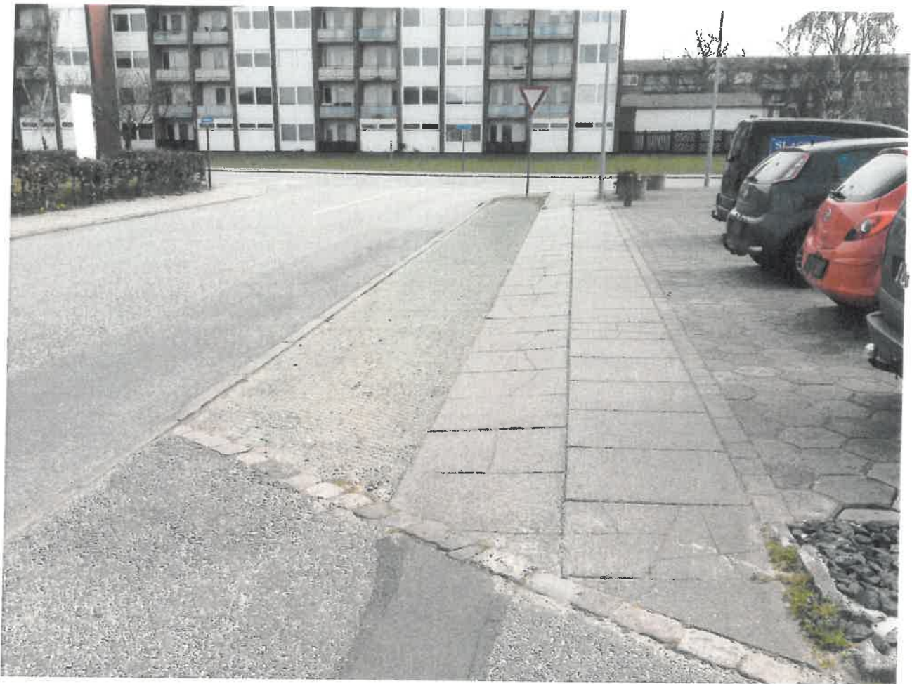
Grønlandsvej. Her er alt græs slidt af ved daglig belastning. De fleste fortovsfliser har sat sig og er knækket fordi det underliggende opbygning kun er dimensioneret til gående. Der er ikke givet nogen tilladelse til hverken overkørsel eller parkering på denne strækning.
