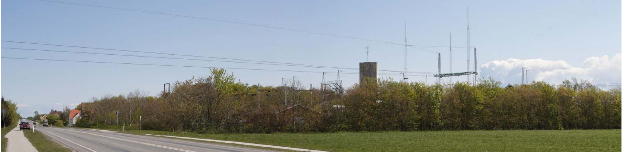
Eksisterende forhold set fra Aalborgvej
