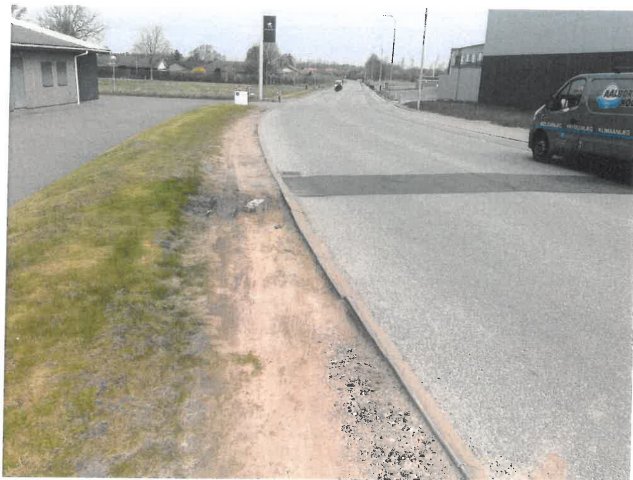
Flade Engvej, rabat opkørt og belastet så meget at også kantsten har taget skade.
