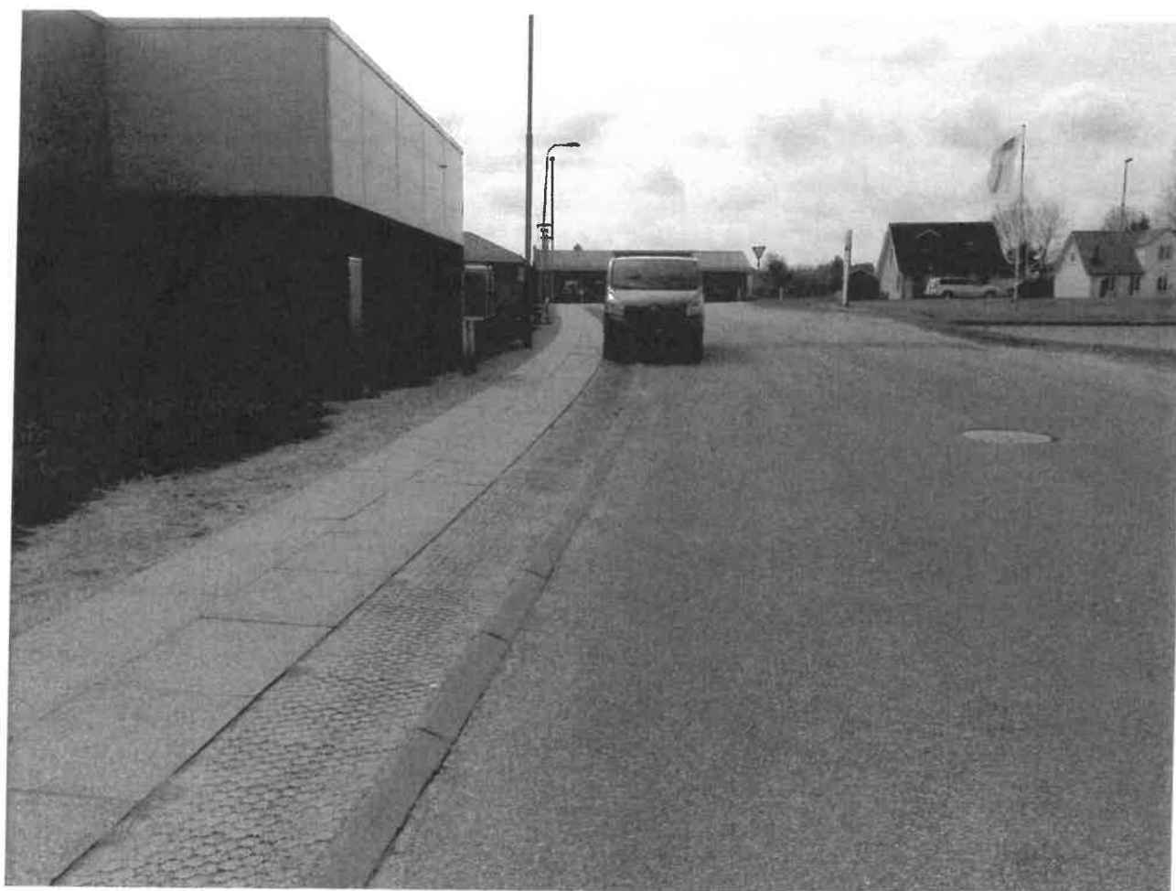
Flade Engvej, øst side, Her er der for flere år siden forsøgt med plast græsarmering . plastiken ligger meget synligt, men der gror ingen græs. Kørebane er rigelig bred til at kunne parkere på denne, hvor lastbiler nemt kan komme forbi. Der absolut ikke være behov for denne parkering i rabat.
