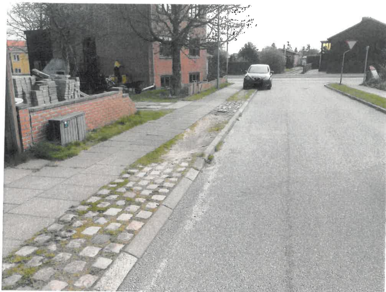
Fanøvej. Daglig parkering og kørsel i rabat hele året. Der kan ses at enkelte fortovsfliser er "vippet" op som skyldes hjuldæk enkelte gange lige holde på kanten af fliserne.
