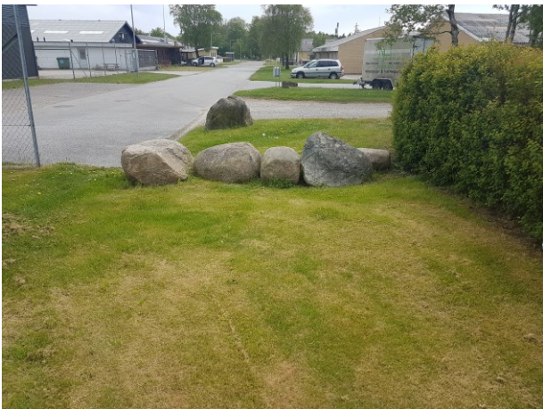
Fallavej – set fra arealreservation for sti.
