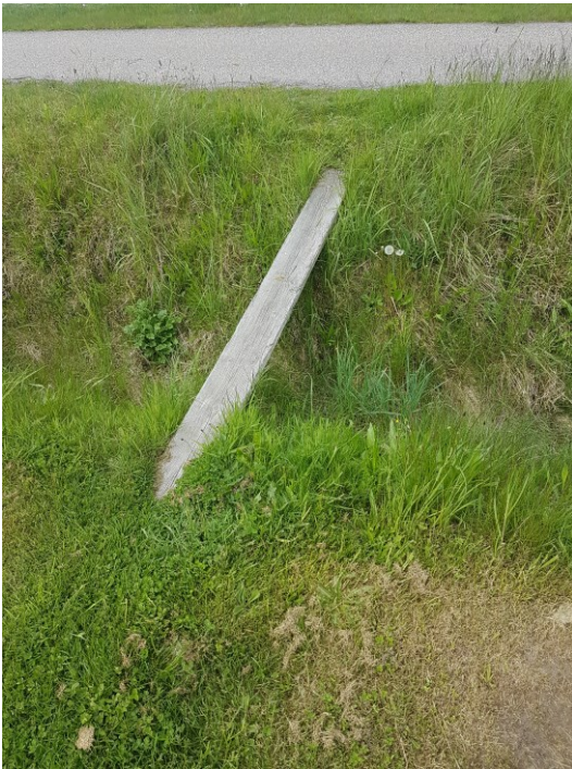
"Plankebro" over grøft langs Ålborgvej.
