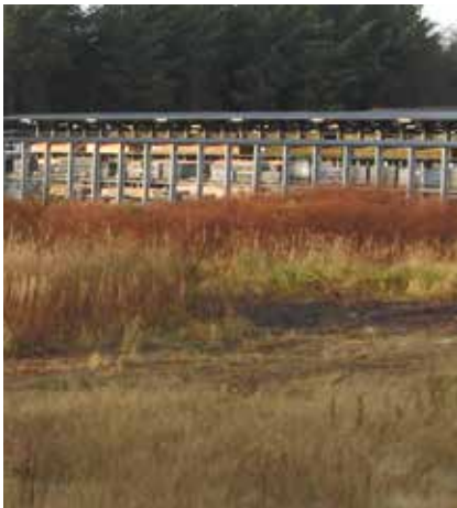
Elling Å i forløbet ved Trælasten
